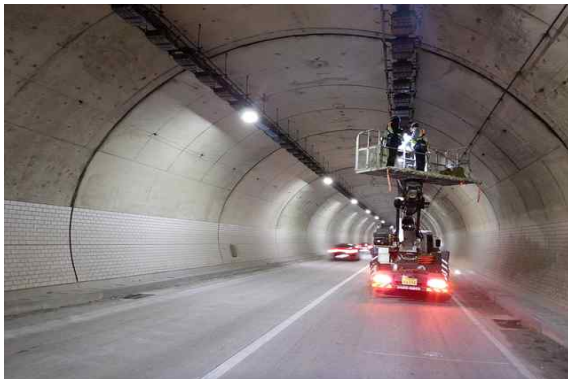
터널 내부 고소점검차 조사
