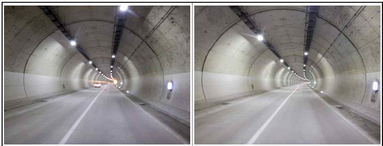
<그림 3.7> 능안터널(상) 라이닝 전경
