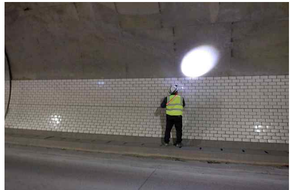
터널 내부 도보조사
